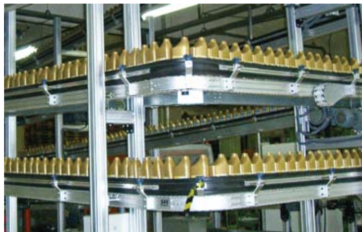
Transportadores alpino (acumulativo) flex line
